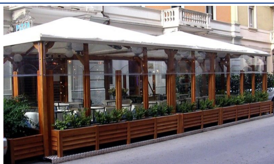
Tipologia B.2: capanno (gazebo), senza chiusura laterale, delimitato o meno da fioriere, a copertura delle tipologie A.1, A.2 e A.3
